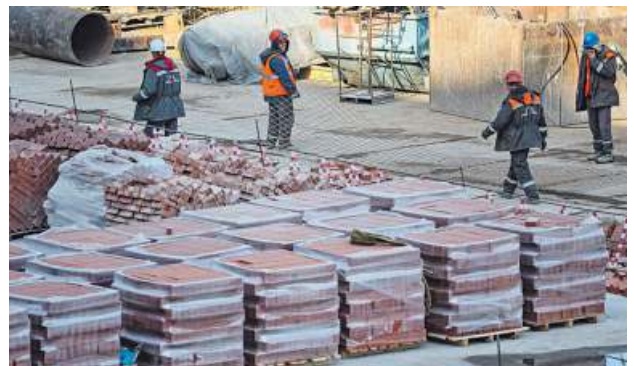
Imagen de varios trabajadores de la construcción levantando un edificio destinado a convertirse en vivienda. Foto: Sergei Ilitsky Efe
