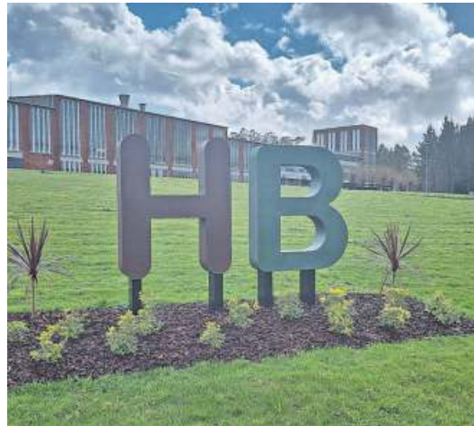
Exterior de las instalaciones de la fábrica HB Betanzos
