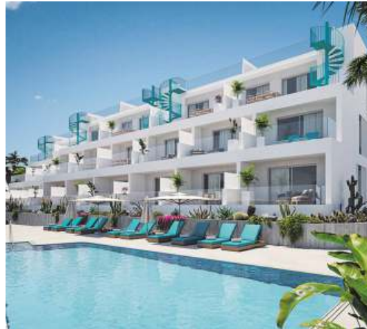
El proyecto cuenta con una piscina climatizada gracias a la energía solar.
