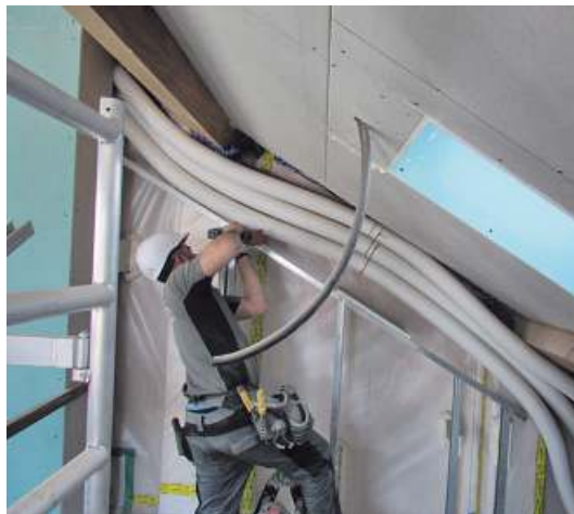
Rehabilitación energética de un edificio en Oleiros realizada por Teuvento
