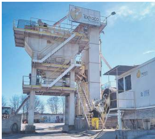
Planta de Extraco en Allariz dedicada a la fabricación de aglomerado asfáltico.
