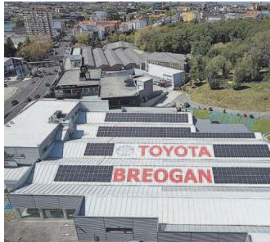
Las amplias cubiertas facilitan la instalación de los paneles solares.
