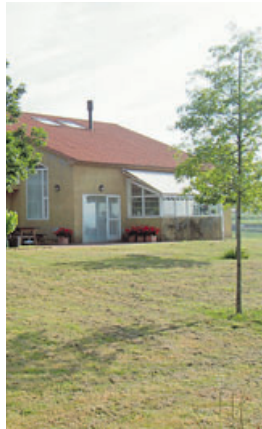
Ejemplo de construcción de una vivienda bioclimática
